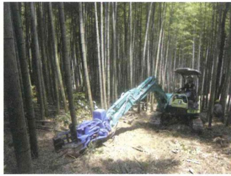
(専用重機による竹林整備)
